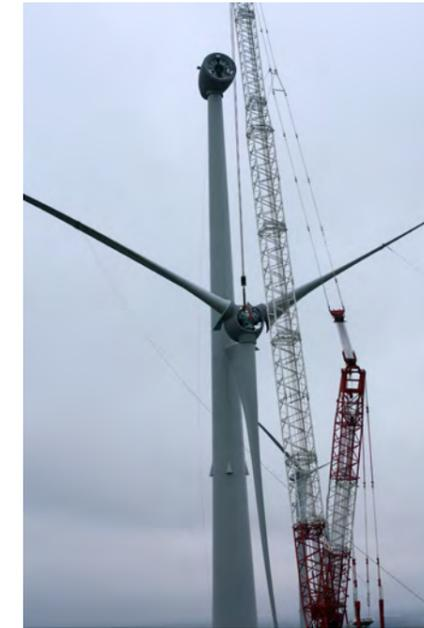
Figure II.2 : Montage d'une éolienne
